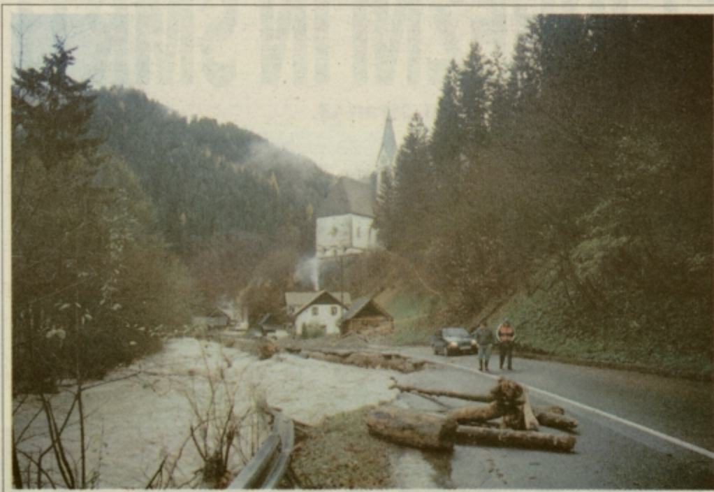
Savinja je povzročila precejšnje zajedje na cesti Luče - Solčava, voda je odnesla tri mostove, gozdne ceste pa so enostavno izginile.
