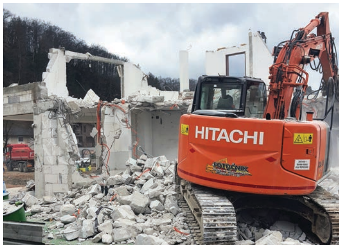
Za rušitvena dela je poskrbela občina.
