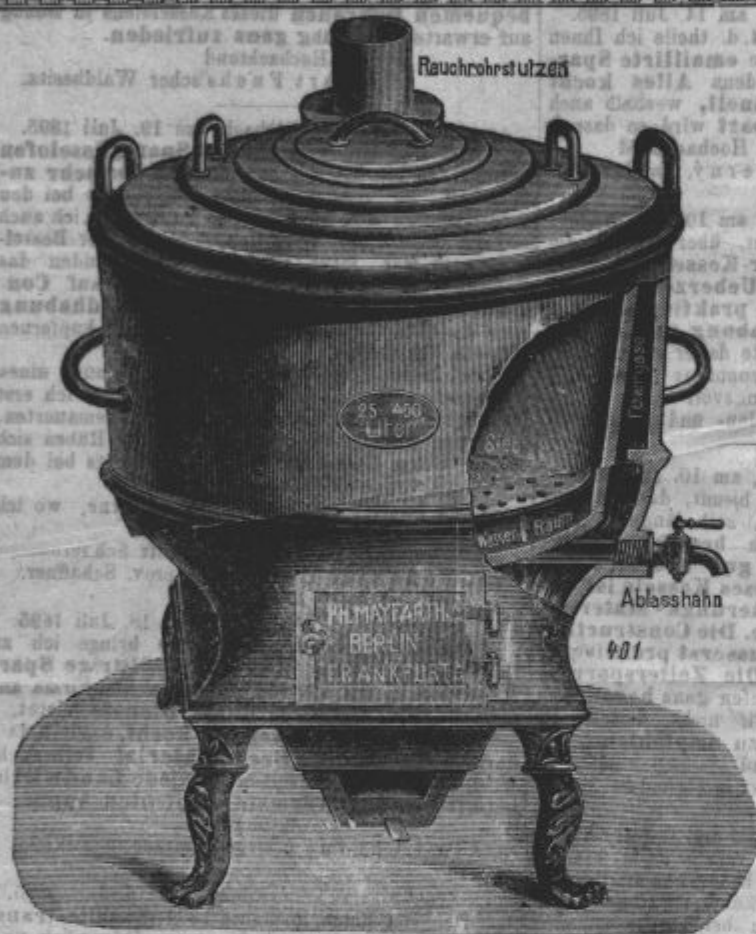
Fig. 1. Transportabler Spar-Kesselofen mit Siebboden, innen emaillirt oder nicht emaillirt.
