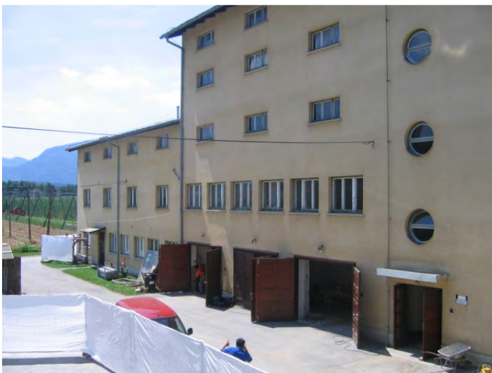
Vzhodni del stavbe ob pričetku del (foto: P. Bukovec in B. Čremožnik, tekst: M. Zupančič)
