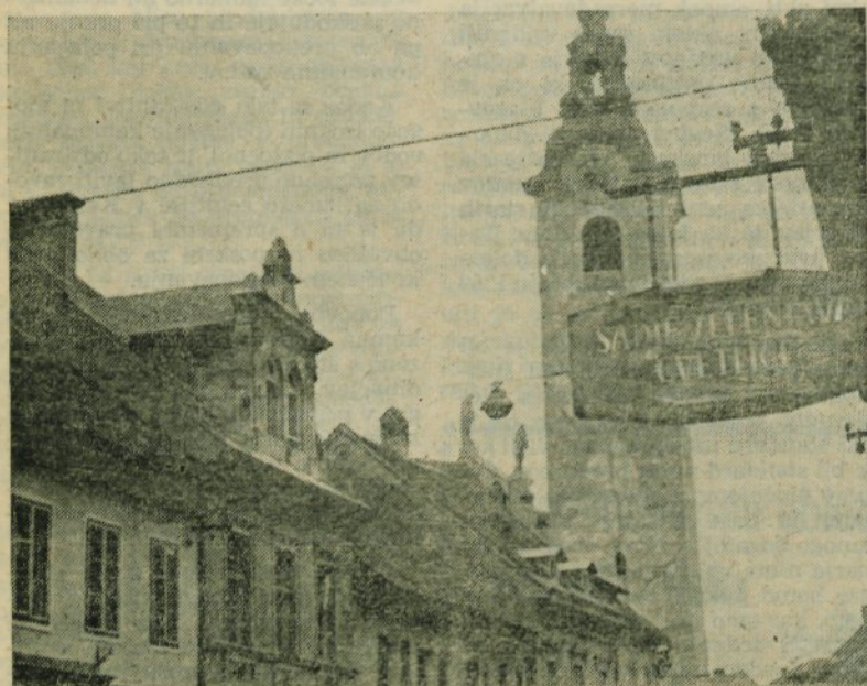
Bakreni reklamni izvesek v Kidričevi ulici
