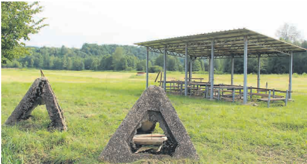
V Apačah bodo naslednji mesec stekla dela. Ministrstvo za obrambo bo zgradilo dve novi strelišči dolžin 50 in 400 metrov.
