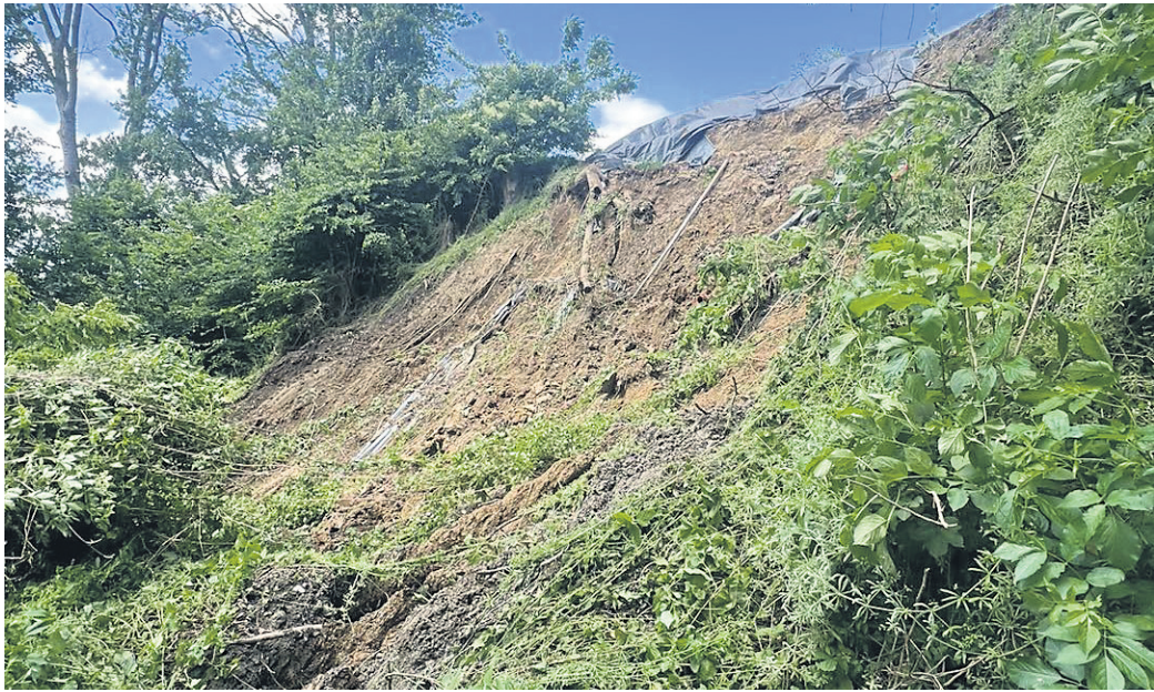
Plazova na hribu pod cerkvijo in Trojiškim trgom trenutno sicer mirujeta, a nevarnost, da bosta zdrsnila proti jezeru, ostaja, zato ju bo treba čimprej stabilizirati s piloti.
