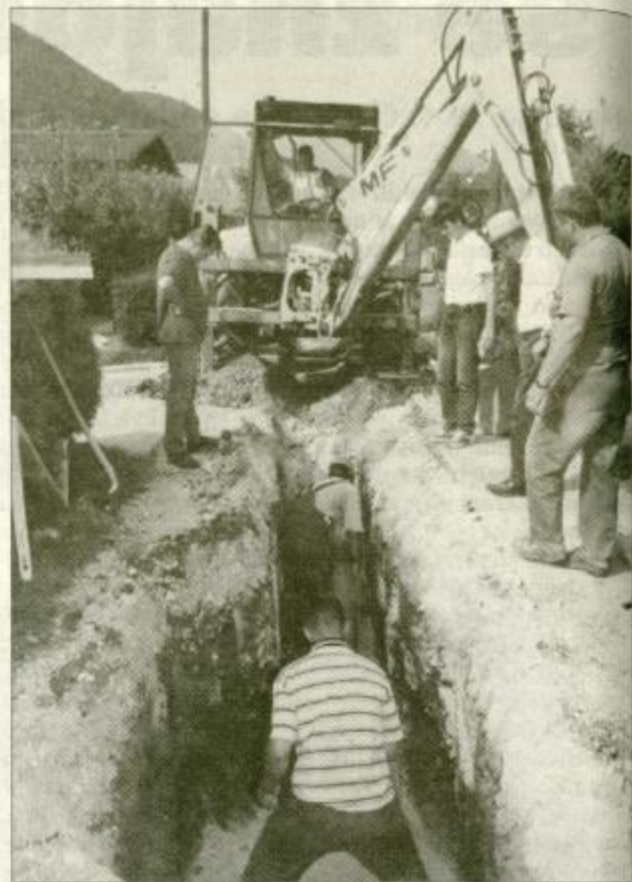
Izgradnja primarnega kanalizacijskega voda v Dolenji vasi.
