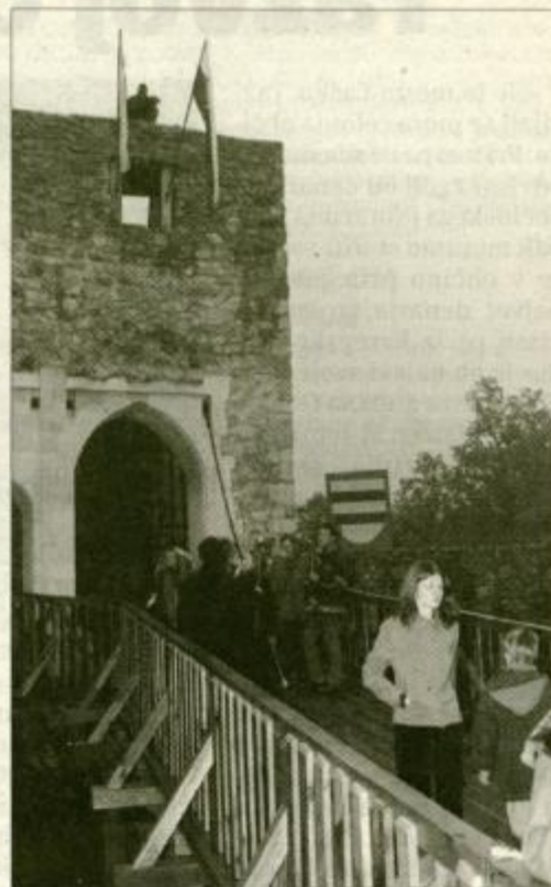
Del mostu in obnovljenega portala na gradu Žovnek.
