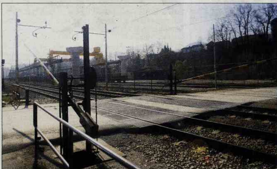
Zaradi nerešenega problema vzdrževanja železniških prehodov za obdobje do leta 2004 prejemajo v občinah v zadnjih tednih sodne izvršbe. Prejeli so ju tudi v Štoreh ter na Polzeli.
