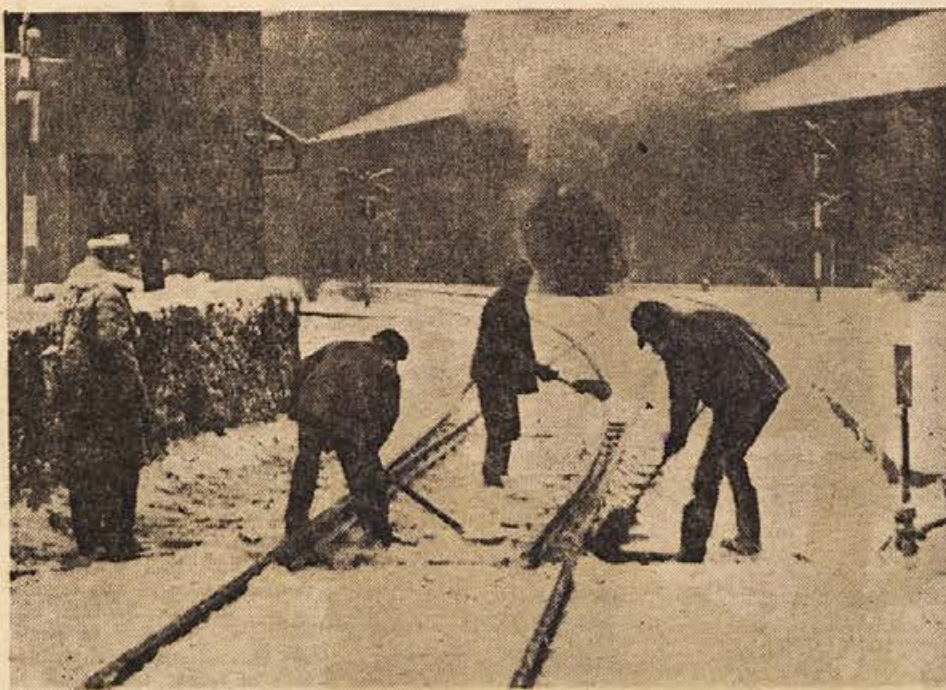
NA KRETNICAH JE NAJBOLJ NEVARNO. Zato morajo progovni delavci najprej očistiti ta del proge, čeprav posel v snežnem metežu ni posebno prijeten. 200 vagonov gre na dan čez industrijske tire tovarne papirja v Krškem in kretnice morajo biti zanesljive (Tone Zalokar si za ta posnetek deli tretjo nagrado za »Fotografijo tedna« z Darkom Pavlinom iz Novega mesta; posneto v soboto, film ORWO NP 20, petindvajsetinka, zasl. 8)
