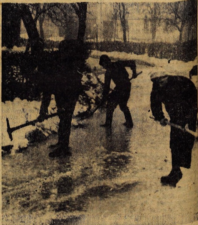
Nenadni dež je marsikje poplavljal ceste. Tako je bilo vsaj v torku jutraj v Strazlišču v Kranju, kjer je bila večina cest skoraj nepre- hodnih. V neposredni bližini doma Partizan pa je bila zaledena toliko slabša, ker je bila zamašena kanalizacija. Ker en sam cestni delavec, ki je bil pred osmo uro v tem predelu, ni bil kos nastali »poplavi«, so morali zadevo reševati seveda tudi ostali.
