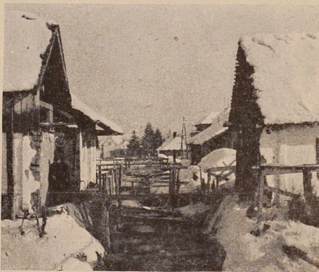
Kanalizacija v M. Soboti — čez dvorišča in hiše
