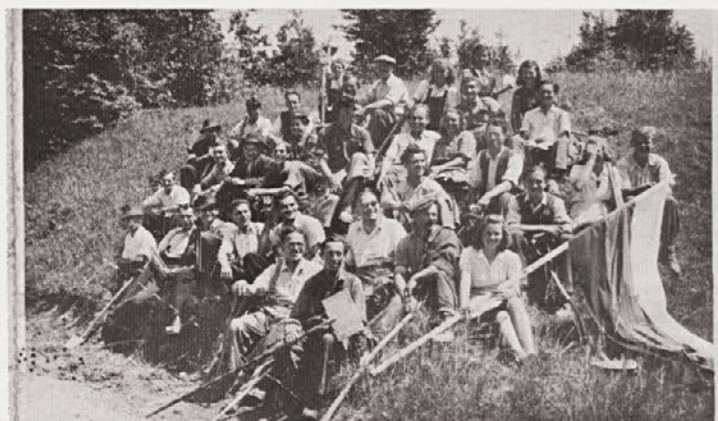
Delavci z žage v Rumanji vasi. Skupina je pripravljala kamen za gradnjo doma KZ v Straži.
