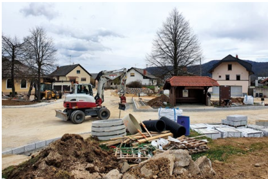
Investicije v glavni fekalni kanal in drugo občinsko infrastrukturo
