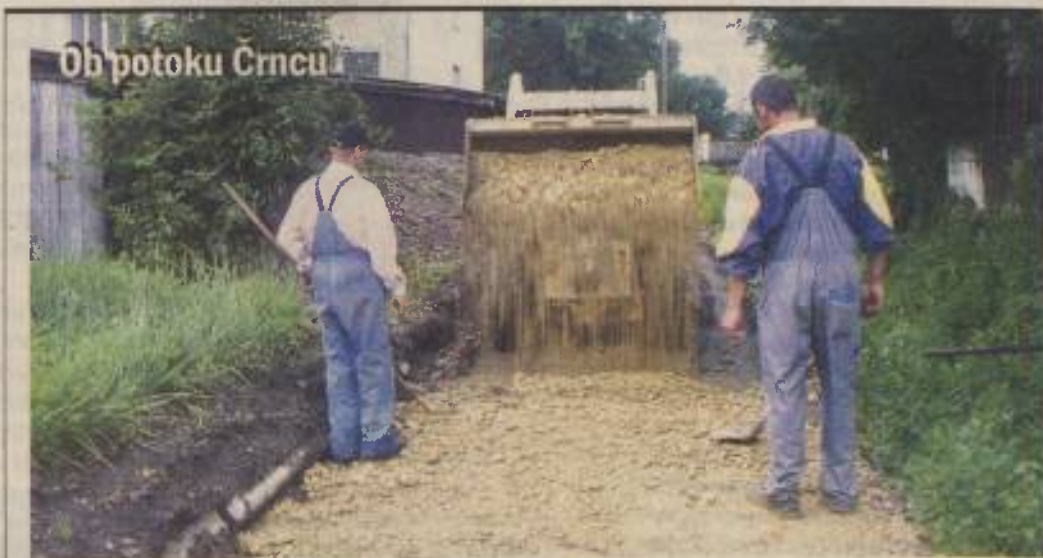
Krajanom tako imenovanega dolnjega konca Beltinec se je te dni uresničila dolgoletna želja, da bi lahko varno prišli do središča kraja. Pešpot med Gregoričovo in Ravensko ulico je še posebej dobrodošla za učence osnovne šole Beltinci. Gradbena dela so zaupali podjetju G. M. V. gradbeništvo Branko Weindorfer Rihtarovci, katero je bilo izbrano kot najugodnejši ponudnik. Vrednost naložbene je ocenjena na nekaj manj kot 3,5 milijona dolarjev. J. Ž.
