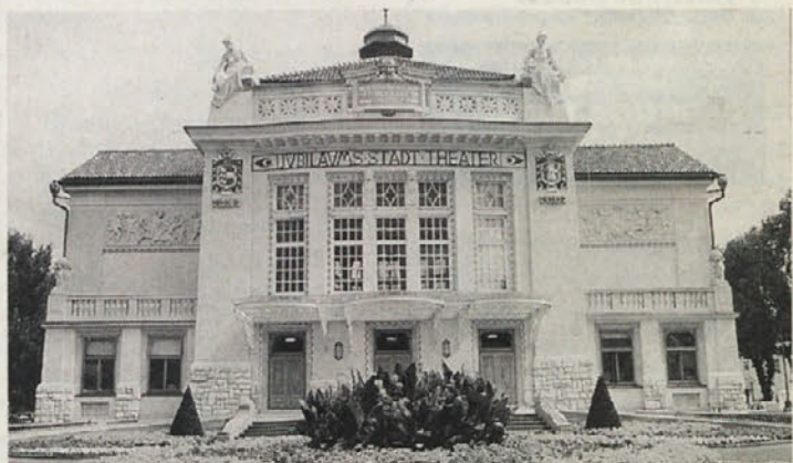
Novo obnovljeno Mestno gledališče – biser Celovca
