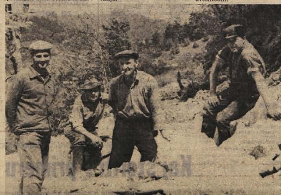
Prebivalci 35 hiš zelo požrtvovalno gradijo cesto med Sodevci in Radenci, dolgo 3,5 km. Do zdaj je vsaka hiša že opravila 4 dni težkega dela, saj je teren skalnat in nevaren. S pomočjo kompresorja in minerca črnomaljske komunale, ki ju plačujejo s samopriskevkom, so navrtali že toliko lukenj, da so porabili več kot 2000 kg streliva. (Foto: Ria Bačar)
