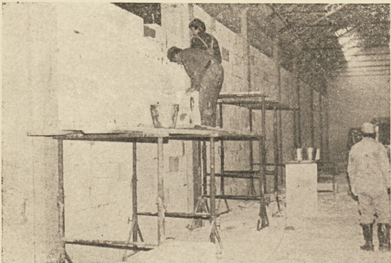
Priprava prostorov v centralnem skladišču za strojegradnjo
