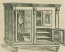
mit entnehmbarem Eisbehälter und ebensolchem Wasserreservoir konstruiert
