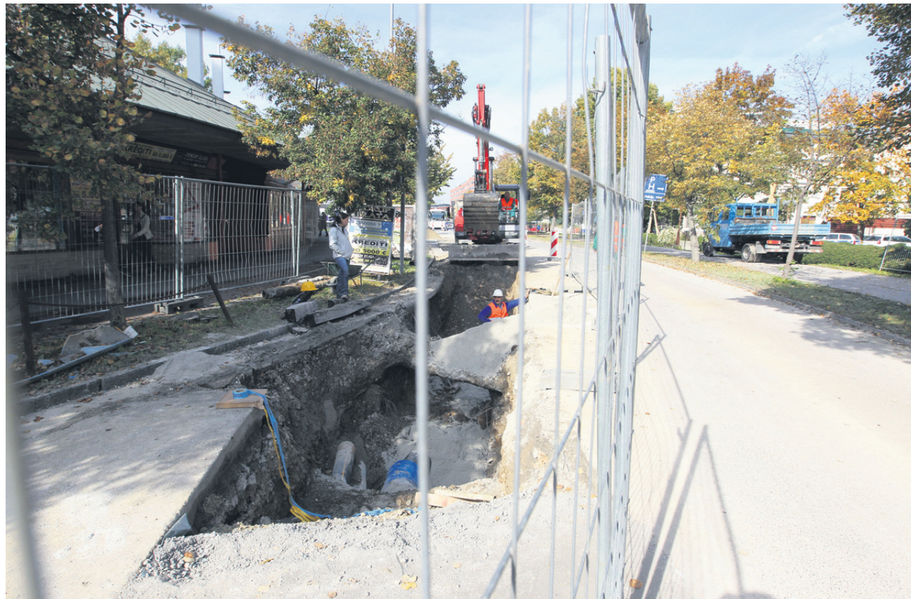
Delna zapora prometa po Ljubljanski cesti bo trajala še nekaj tednov. Oba komunalna voda so začeli obnavljati v križišču z Gregorčičevo ulico, cevi pa bo treba zamenjati vse do poslopja Srednje šole za storitvene dejavnosti in logistiko.
