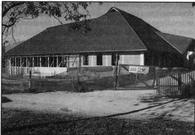
Gradbena dela na rečiški šoli naj bi znova stekla v teh dneh (foto: B. Kanjir)
