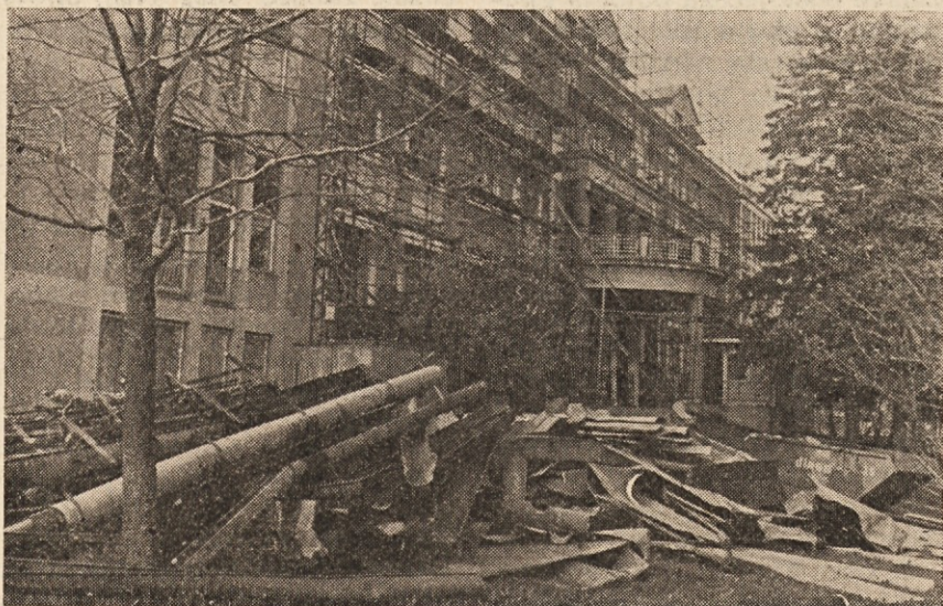
Osrednji del splošne bolnišnice Trbovlje. V aprilu in maju t.l. obnavljajo objekt, ki je star že 57 let (zgrajen je bil leta 1925) in nujno potreben temeljite obnove. Obnovili so streho, žlebove, odtočne cevi in fasado.
