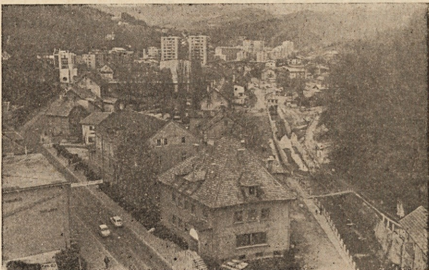
Center Zagorja se spreminja iz dneva v dan. V zadnjih mesecih je v gradnji v neposredni bližini zgradbe občinske skupščine in delavskega doma, nova stanovanjska zgradba-stolpnica z nekaterimi poslovnimi prostori.
