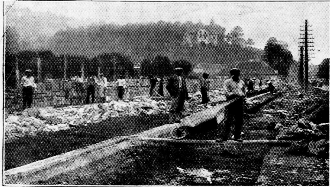
Pogled na gradnjo tramvajske proge v šiško
