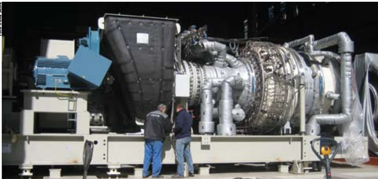
Montaža druge plinske turbine PT52 v TEŠ.
