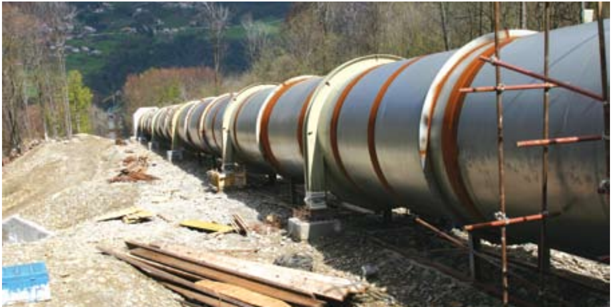
Nadzemni del cevovoda je v večjem delu zmontiran.
