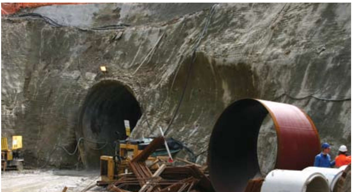
Zaključna dela pri 700 metrov dolgem dovodnem tunelu.
