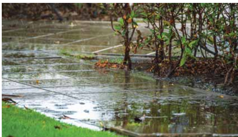
Slika 7: Nakloni površja preusmerjajo ploskovni odtok deževnice.
