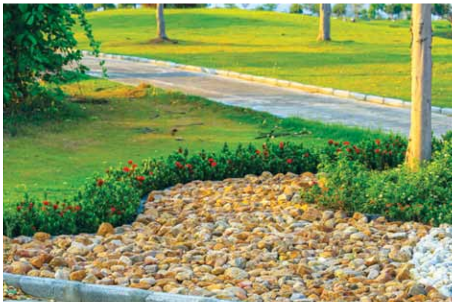
Slika 1: Bioretencijski sistem ima nasute prodnike v neposredni bližini koreninskih sistemov.
