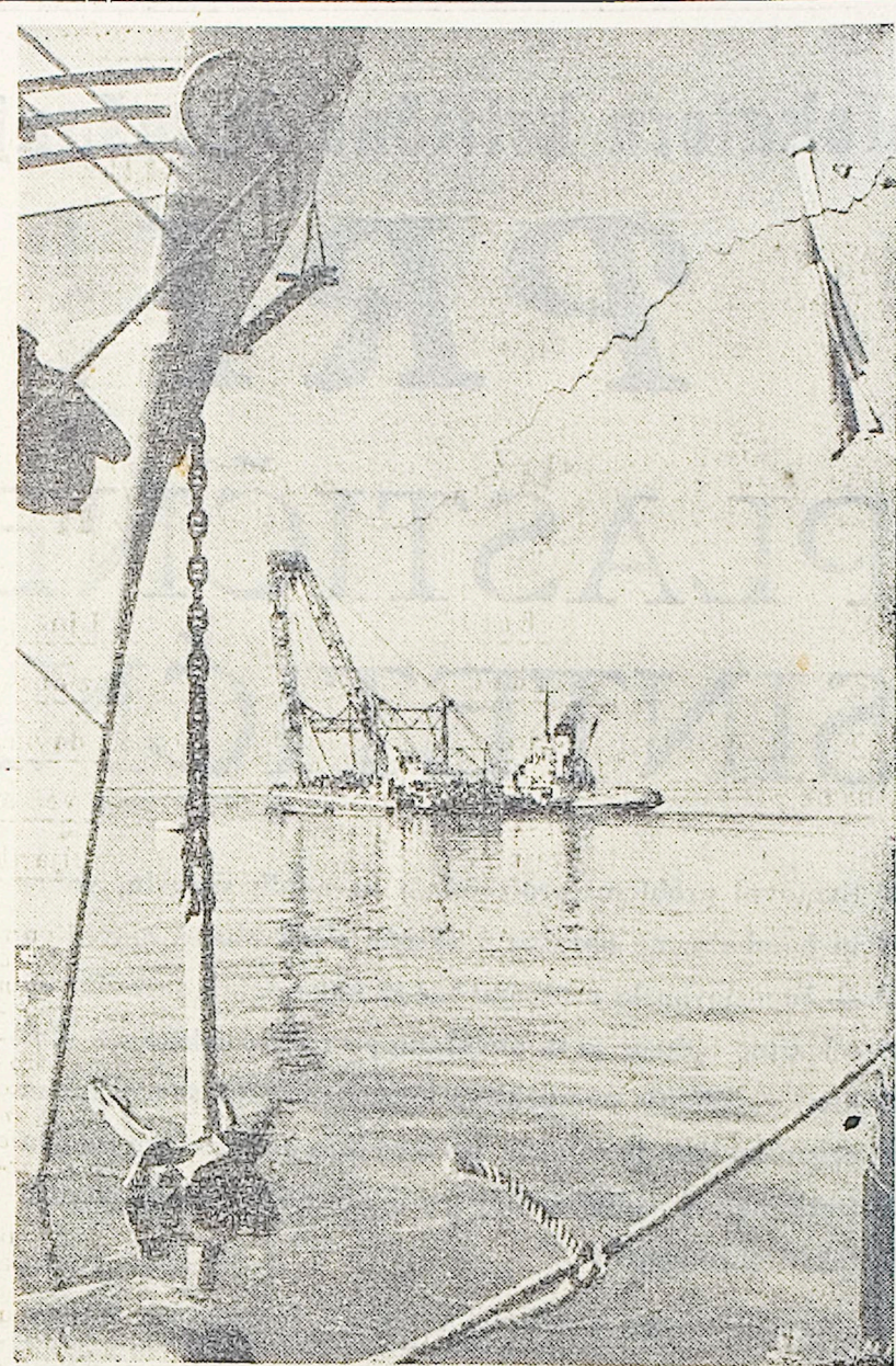
Izgradnja koprškega pristanišča je neločljivo povezana z orjaškim pomorskim dvigalom z Reke. »Veli Jože« z lahkoto dviga 100-tonske bloke iz armiranega betona in jih s provizoričnega gradbišča v starem pomirskem pristanišču prevaža in postavlja na mesto, kjer bo prihodnja stoletja stala operativna obala koprške luke. Te dni bo takšnih 100-tonskih blokov položil 187 in se bo s tem operativna obala podaljšala na 550 metrov, tako da bodo hkrati lahko tri do štiri čezoceanske ladje pristajale v Kopru
