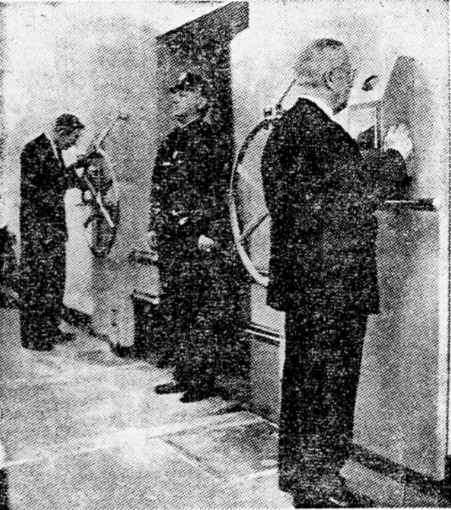
Kaj je vse potrebno, da se vrata v trezor odpro. Dva izmed treh mož, ki so poklicani odpirati jednoklena vrata. Vsa pozna le svojo kombinacijo, ki združene sprožijo mehanizem za odpiranje teh jednoklenih vrat.
