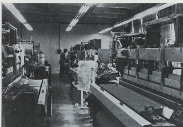
Brezčolnične statve omogočajo brezhibno delo — Jarše 1978
