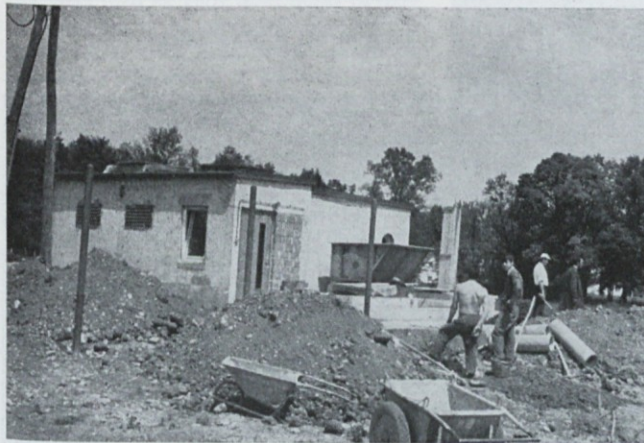
Gradnja čistilne naprave za odpadno vodo. Leto 1974
