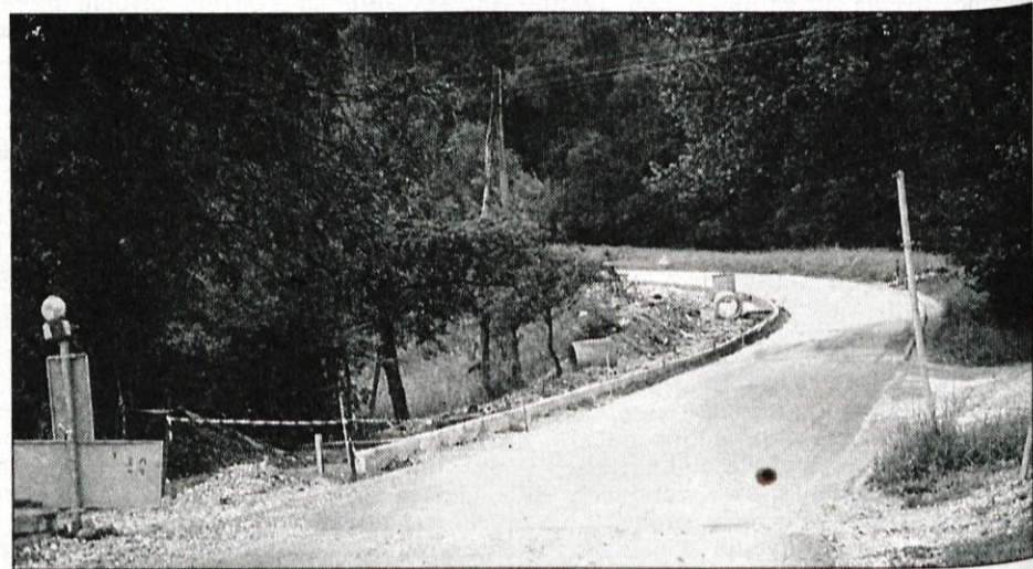
Preddvor, 26. junija - Cesto od Jelovice proti središču Preddvora so že nekaj časa obnavljali. Poleg ceste so uredili tudi vso meteorno kanalizacijo. Pod klancem so najprej nameravali narediti peščen hodnik za pešce, pozneje pa, ko je bilo vse prekopano, so se odločili za asfaltni pločnik. Dela so bila do praznika večidel končana, le na vrhu klanca na Francarji, še delajo, kajti cesta se na tem mestu precej razširi in seže tudi v hrib, kar je zahtevnejše kot na drugih odsekih. Sicer pa so v Preddvoru veseli, da imajo urejeno še eno precej prometno cesto in da je z obnovo poskrbljeno tudi za večjo varnost pešcev. - Foto: Tina Dokl
