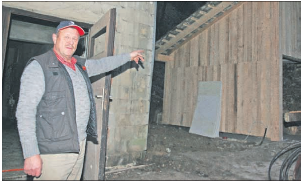
Predsednik Kulturnice Gaberke Franc Štehnar ob vhodu v hišo, ki jo Anžejevi poskušajo dokončati že več kot dve desetletji. Na zunaj ni nič kaj prida videti, a dobri ljudje so že poskrbeli, da se vsaj od znotraj izvaja nekaj osnovnih gradbenih del. »Če bi vsaj usposobili prostore, ki jih ljudje nujno potrebujejo za normalno bivanje, bi bilo veliko,« pravi Štehnar.
