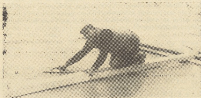
Anton Varga iz Slovenske Bistrice pri ravnanju betonskega tlaka v veliki hali nove valjarne v IMPOLU
