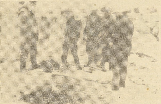
V 14-metrski luknji, ki so jih izvrtali za globinsko čelno miniranje v Kopru, so položili 800 kg razstreliva. Zadnji trenutki pred miniranjem
