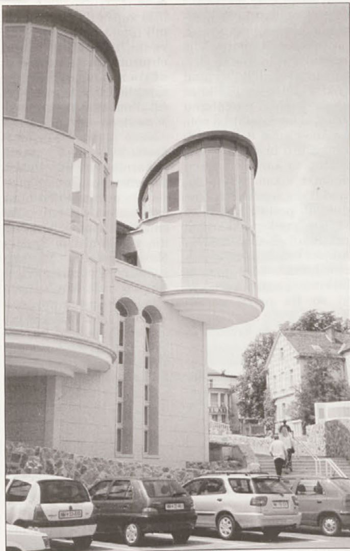
Severni del novega prizidka Knjižnice Mirana Jarca z orientalskimi okenskimi oboki spominja na nekdanjo obrambo mesta pred Turki, stolpiča pa na obzidje, ki je včasih varovalo mesto tudi pred drugimi nadlogami (Foto: Tone Gošnik)
