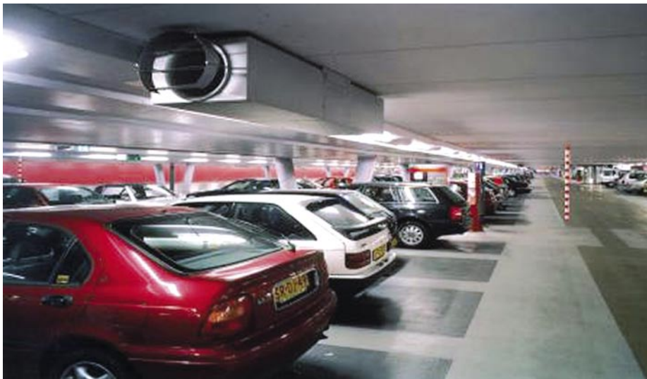
Slika 2 • Impulzni ventilator. Ta tip je skoraj kratki kanal. V sredini se nahaja ventilator, ki sesa zrak iz garaže skozi šobo na enem koncu in piha skozi šobo na drugem koncu (glej sliko). Izvor: Firma Novenco na spletu – brandveilig.com.
