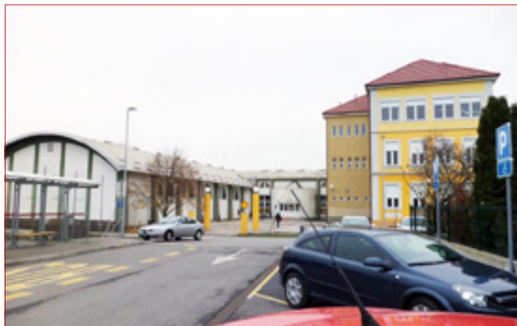
OŠ Breg pred energetske sanacije in po njej.
