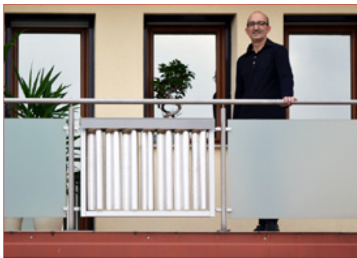
Vetrni panel, vgrajen v balkonsko ograjo.
