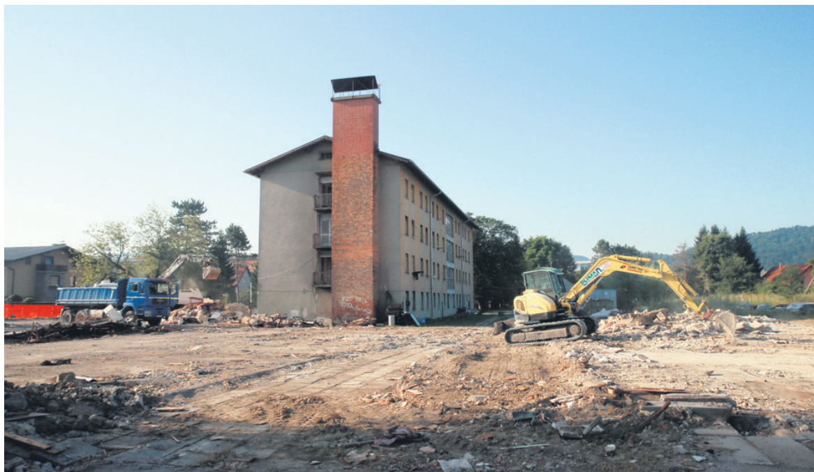
Družba Anepremičnine je porušila dotrajane stavbe propadlega Gostinstva Celje.
