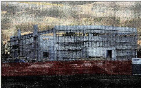
Ogled nove večnamenske športne dvorane že stoji.
