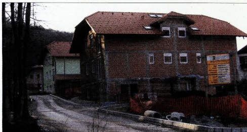
V Dragi pri Štorah gradijo že drugi blok, namenjen zaposlenim pri obrtnikih na območju štirih občin celjske upravne enote. Blok je trenutno v četrti fazi gradnje.
