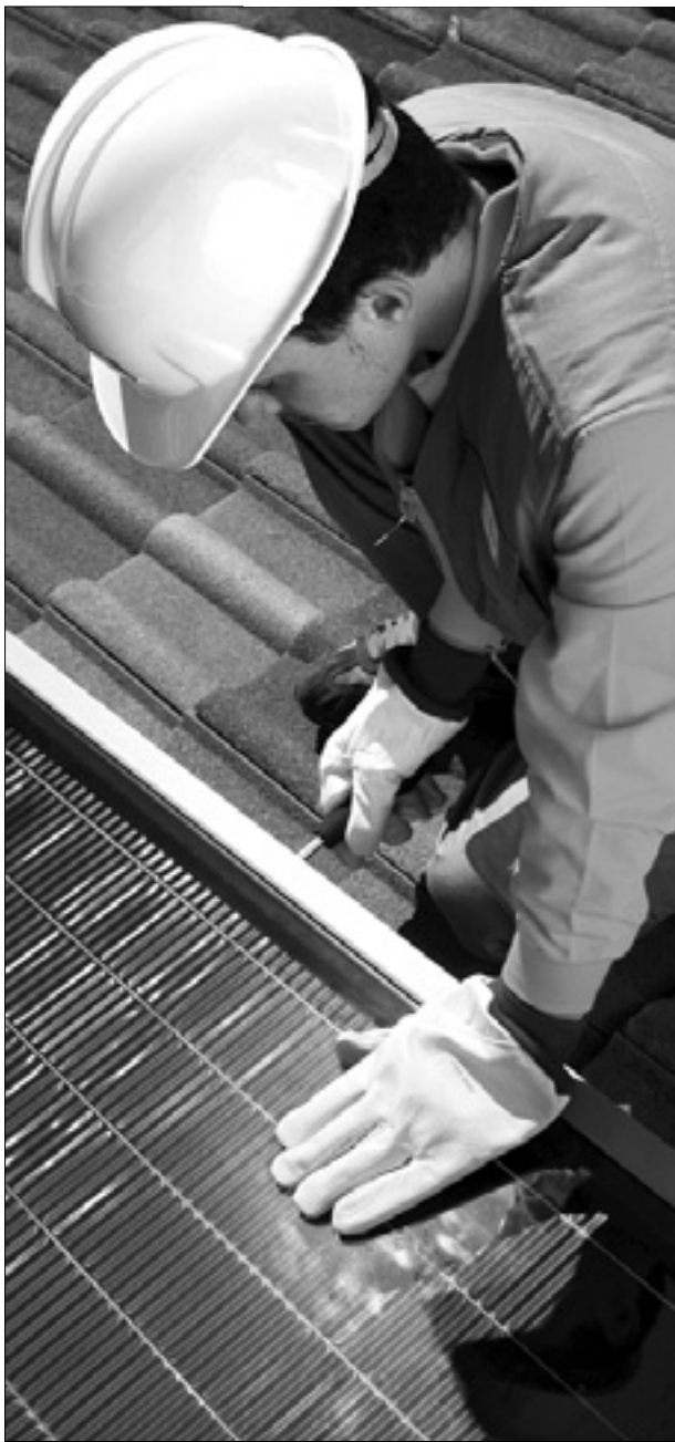
Nameščanje fotovoltaičnih panelov
