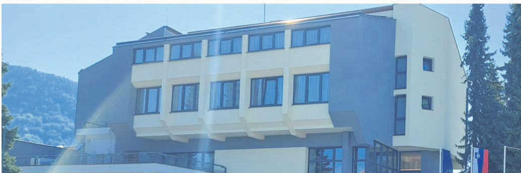
Hotel Prebold je dobil novo, predvsem varčnejšo zunanjo podobo. Že lani so izolirali veliko dvorano, sistem ogre- vanja na plin zamenjali s toplotnimi črpalkami in na strehi postavili sončno elektrarno.
