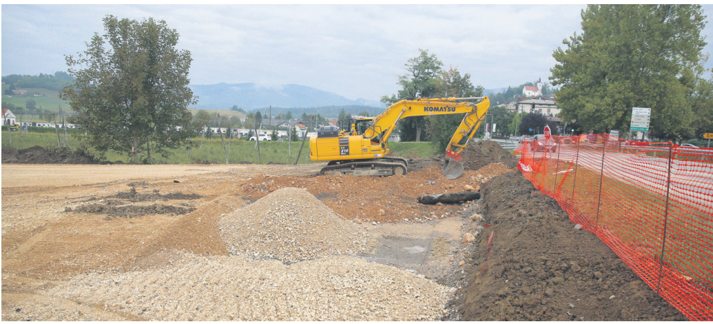
Ob regionalni cesti že raste nova obrtna cona. Razprostirala se bo na več kot 7700 kvadratnih metrih površine, na njej bo približno 4500 kvadratnih metrov velik kompleks, v katerem bo 13 ločenih enot.
