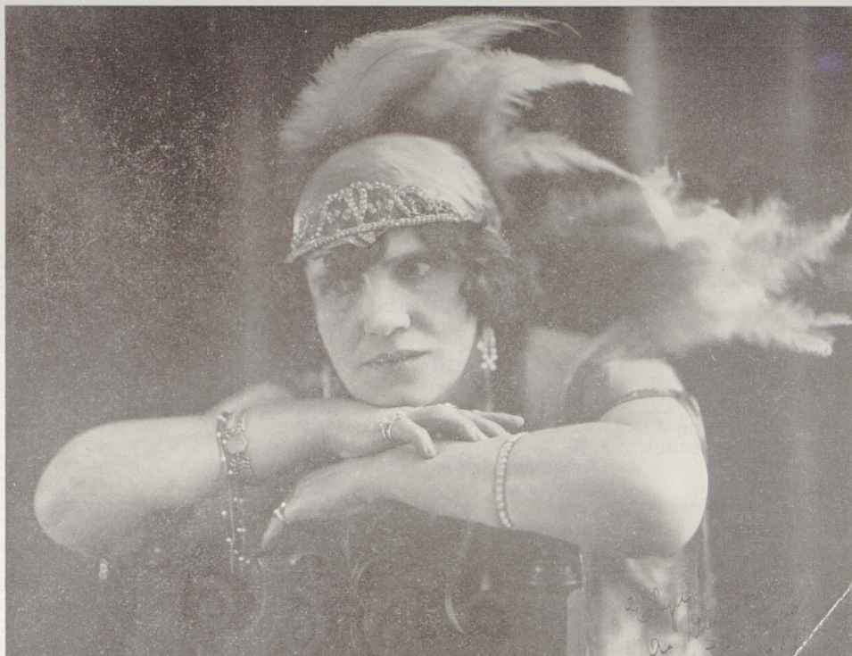
V vlogi Elge v Hauptmannovi »Elgi« v Clevelandu 1925
