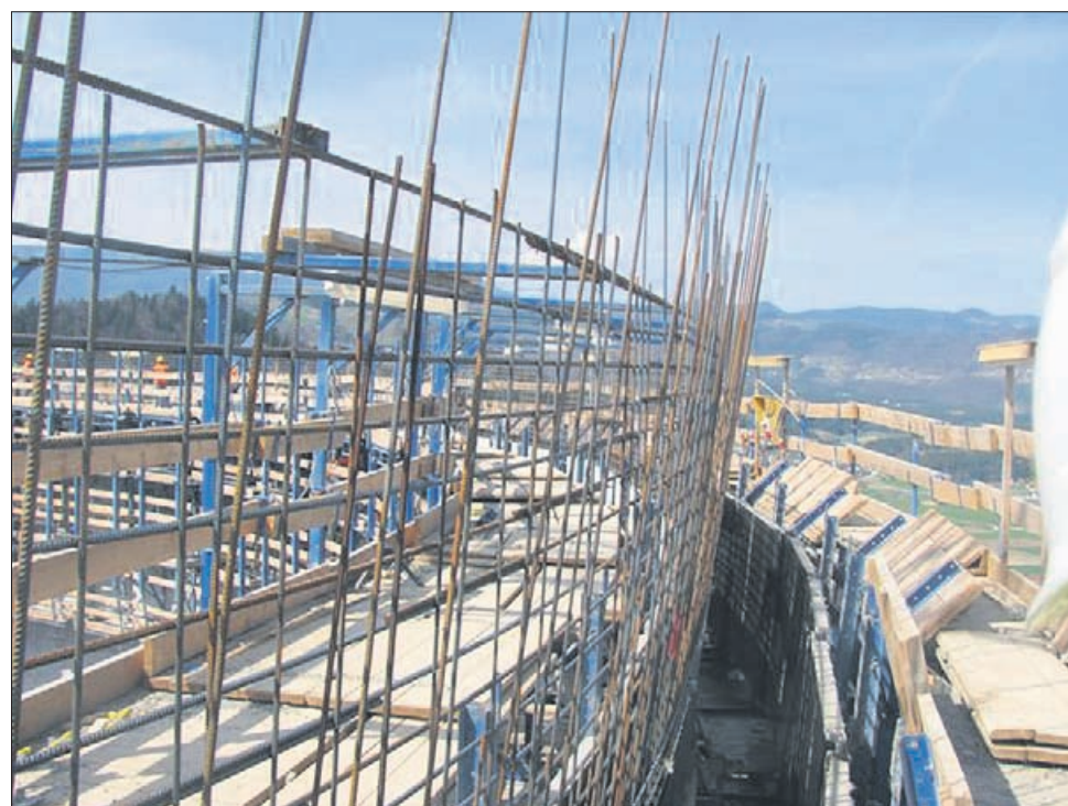
Gradbišče bloka 6 je zadnje dni spet zelo obljudeno, saj na njem dela 400 ljudi.
