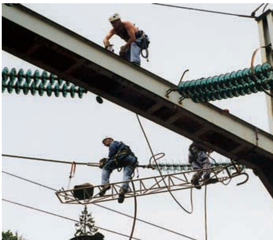
Vzdrževalna dela v 220 kV stikališču.
