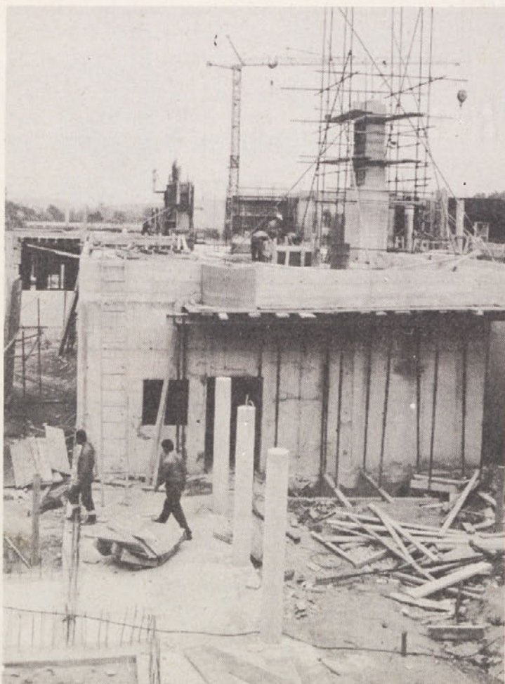
Kljub govoricam, da bo gradnja nove šole v Vavti vasi ustavljena, je na delovišču zelo živahno.
