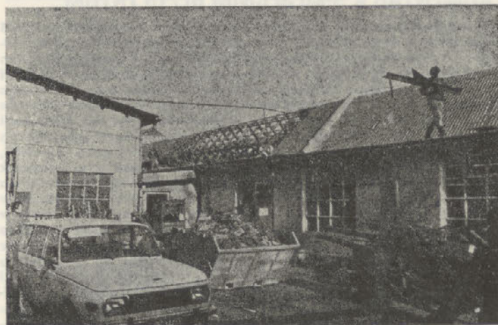
Streha na delovnih prostorih TOZD PM že dobiva novo podobo
