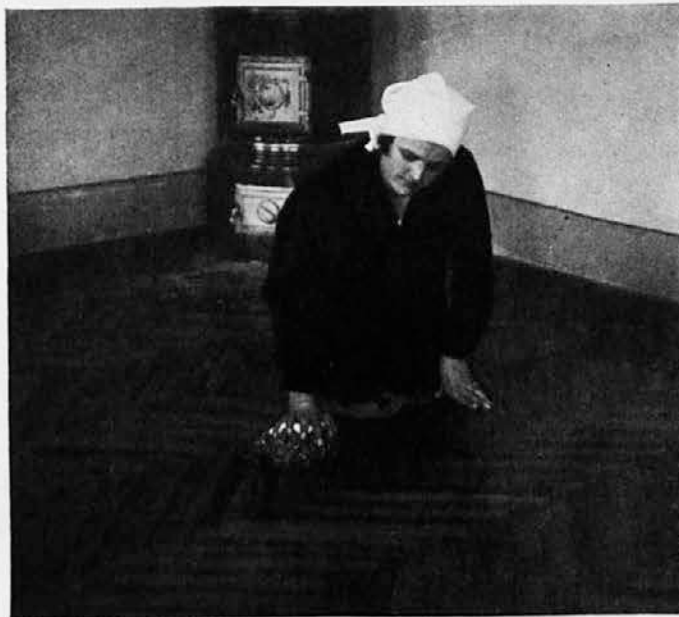
Slika 1. Parketne deščice snaži z jeklenimi ostružki v smeri lesnih vlaken
