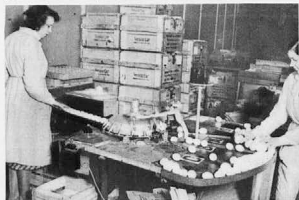
Levo: Mehanična tehtnica, ki sortira jajca po teži
