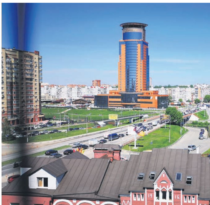
Nedokončan hotel v središču Ščjolkovskega kot žrtev gospodarske krize in poslovnih nepravilnosti. Oblasti so napovedale rušenje, če ga lastnik ne bo kmalu dokončal.
