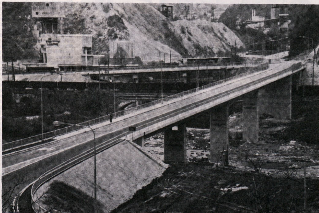
Most čez Savo v Zagorju — to je že drugi most, ki ga je Ingrad zgradil po novi tehnologiji »s potiskanjem«. Odprli so ga 9. oktobra, trak je slovesno prerezal Miha Marinko. Izvajalec del TOZD GO Laško
