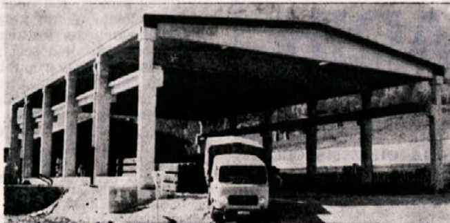
Hala z montažnim sistemom Ingrad za Montano v Libojah
