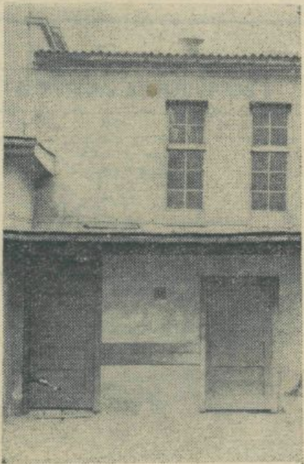
Zaprti vhod v zaprti bazen
