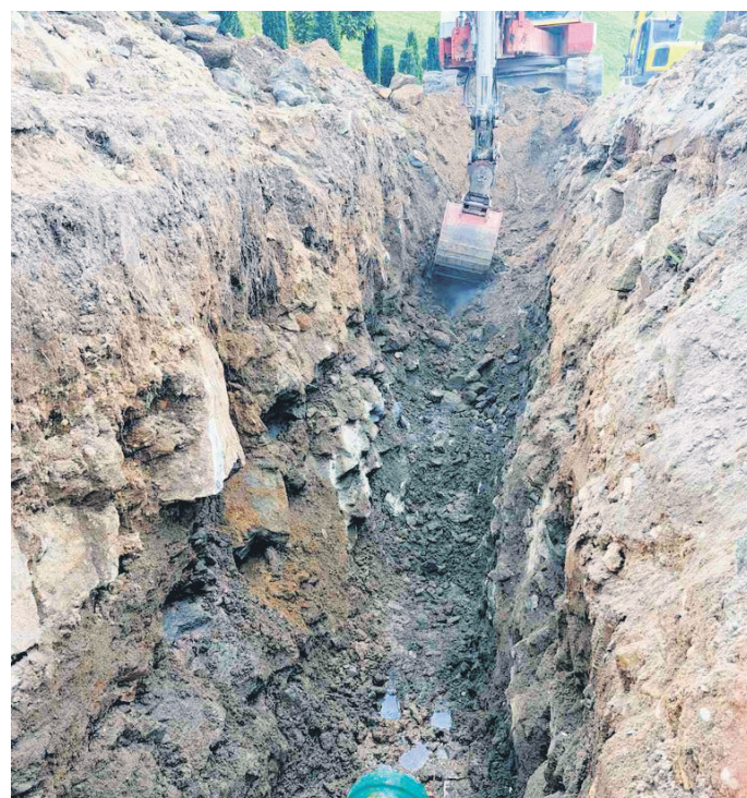
V sklopu gradnje kanalizacijskega sistema v Ivenci je bilo položene več kot tri kilometre fekalne kanalizacije, urejenih je bilo 55 hišnih priključkov. Naložba je obsegala tudi gradnjo padavinske kanalizacije, obnovo vodovoda, dograditev javne razsvetljave in obnovo cestnih površin.
