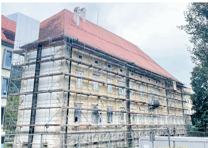
Pogodbena vrednost gradbenih del znaša malo manj kot 781 tisoč evrov. Gradbena dela bodo končana sredi maja prihodnje leto. (Foto: MOC)
