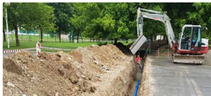
Vzroka za obnovo vodovoda na Šolski ulici sta dotrajanost in prilagoditev trase vodovoda načrtovani gradnji Večnamenske športne dvorane Mengeš
