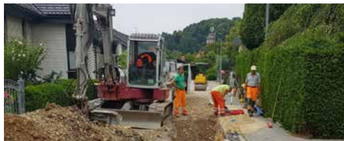
Na Šubljevi ulici bo do konca avgusta obnovljen glavni vodovod v dolžini 270 m in 29 hišnih priključkov
