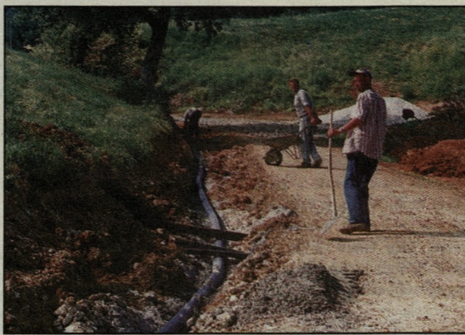
Ob cesti polagajo drenažne cevi.
