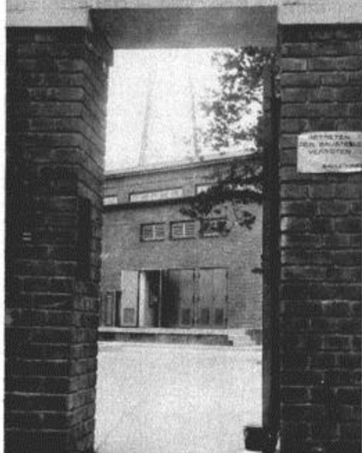
Die neue Sendeanlage im Entstehen
